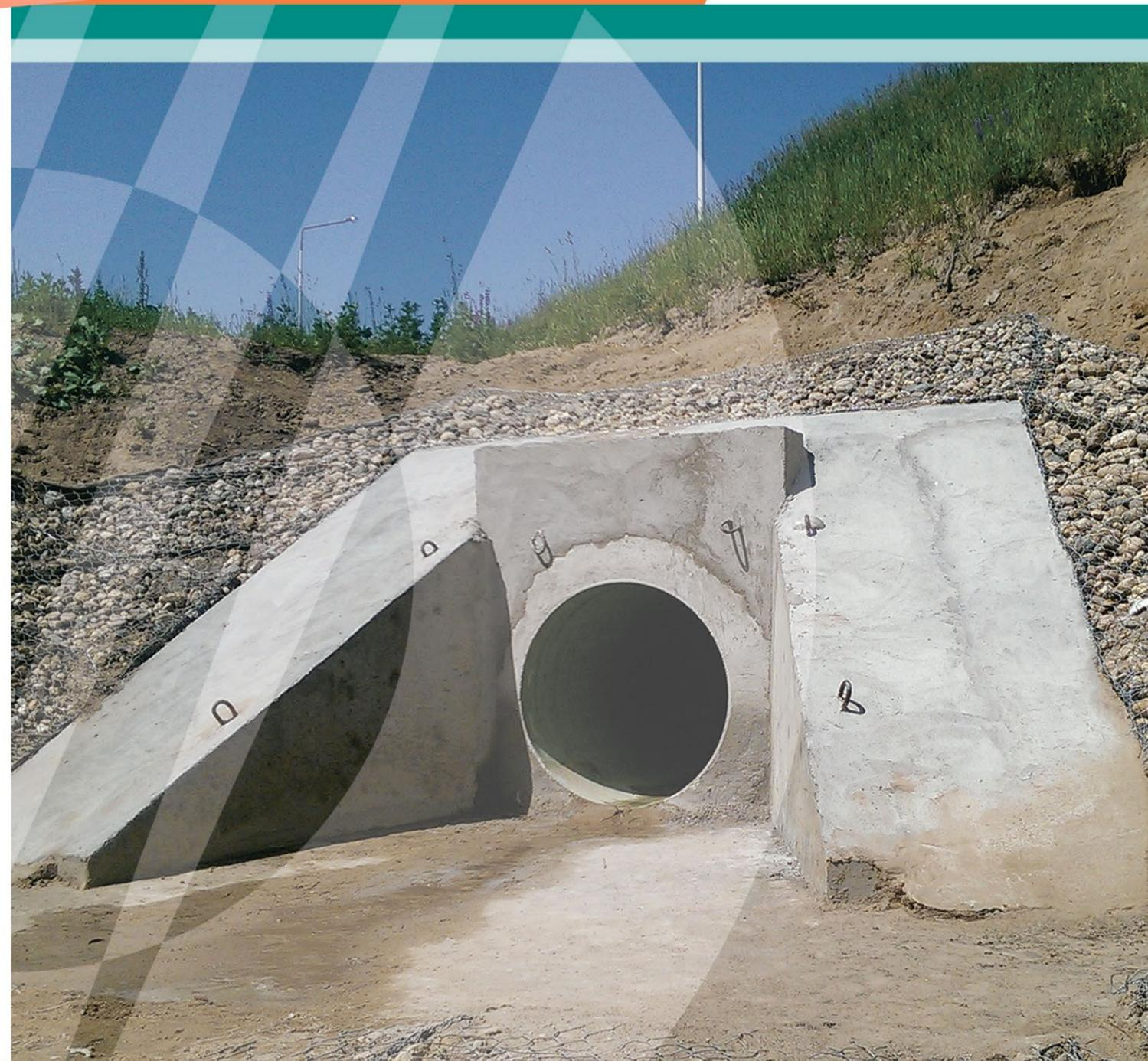
Водопрпускные трубы представляют собой искусственные сооружения, предназначенные для пропуска постоянных или периодически действующих водотоков под насыпями автомобильных и железных дорог.
