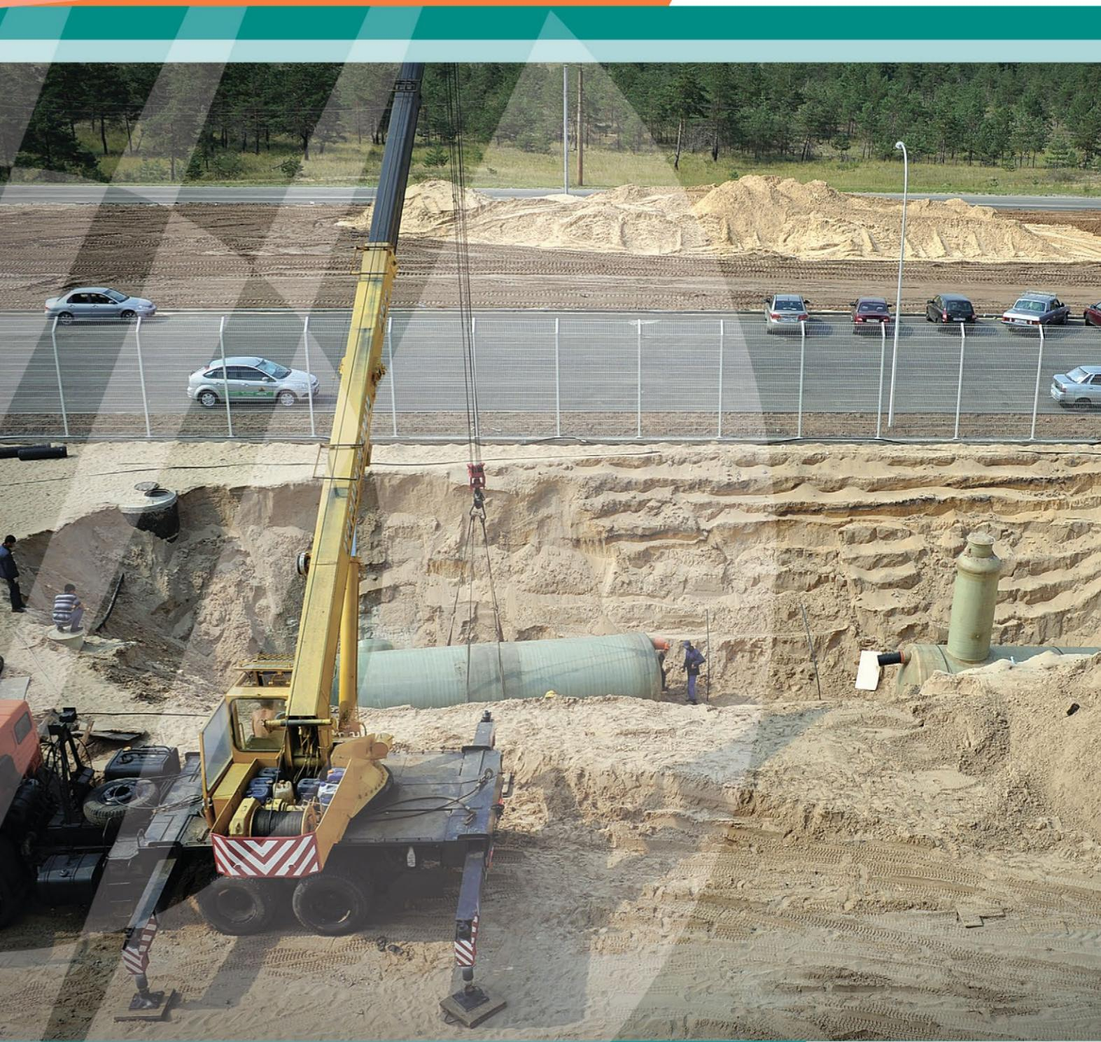
Водным законодательством РФ запрещается сбрасывать на рельеф неочищенные до установленных нормативов дождевые, талые воды, организованно отводимые с селитебных территорий и площадок предприятий. Очистные сооружения поверхностного стока обеспечивают очистку сточных вод до необходимых норм сброса и предотвращают загрязнение окружающей среды различными примесями природного и техногенного происхождения.
