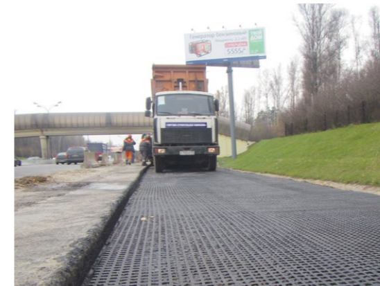
Укладка георешетки ССНП-ХАЙВЕЙ, МКАД 57 км
